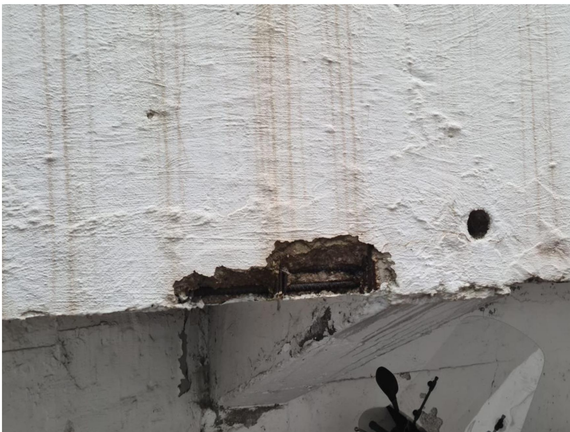
Krycia vrstva, obnažená výstuž
